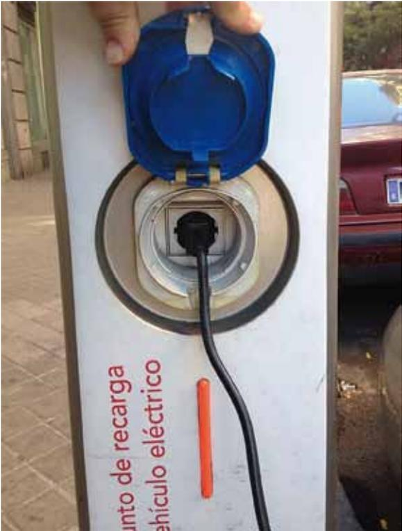
Clavija de conexión no válida para enchufes en ángulo recto
