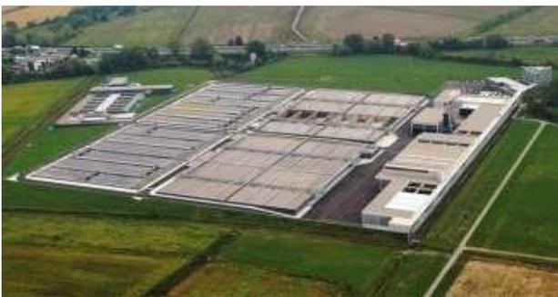
La EDAR Milano San Rocco gestiona el 40% de las aguas residuales de la ciudad de Milán y una parte del vertido del municipio de Settimo Milanese (población equivalente a 1.050.000). Se encuentra al sur de Milán, en una finca agrícola protegida. La planta descarga directamente en el río Lambro Meridionale y en los cuerpos de agua conectados a la red de riego, Roggia Pizzabrusa y Roggia Carlesca, durante los meses de máximo calor.
